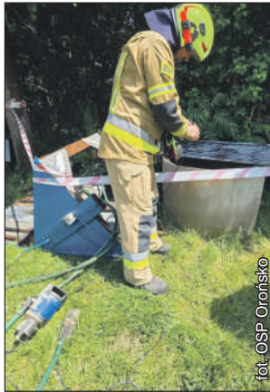
Pożar pompy elektrycznej w studni oraz jej zabudowy na jednej z prywatnych posesji
