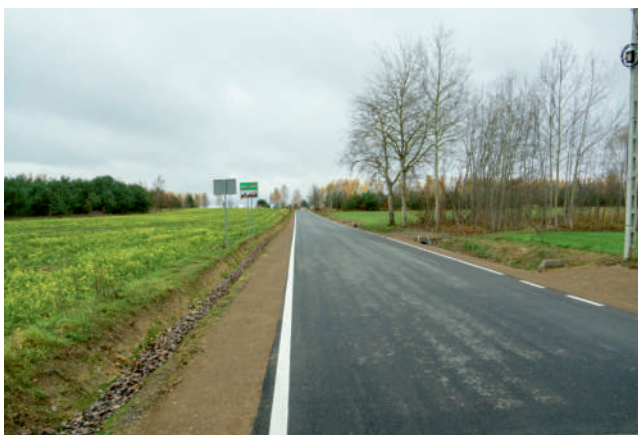
Przebudowa drogi powiatowej Łaziska – Zaborowie - Zastronie
