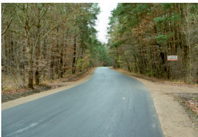
Przebudowa drogi powiatowej Wolanów – Orońsko
