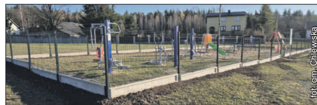
W miejscowości Koszorów zakończono prace związane z ogrodzeniem placu zabaw
