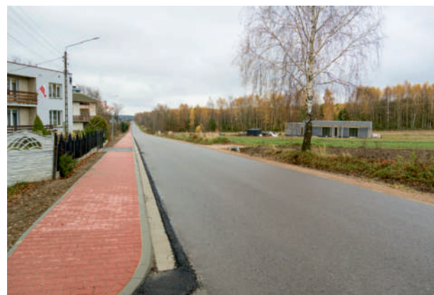
Budowa chodnika w Zbijowie Małym
