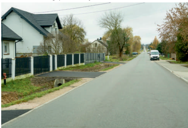
Budowa chodnika w Mirowie Nowym
