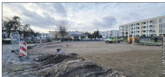
Trwa budowa miejsc parkingowych
