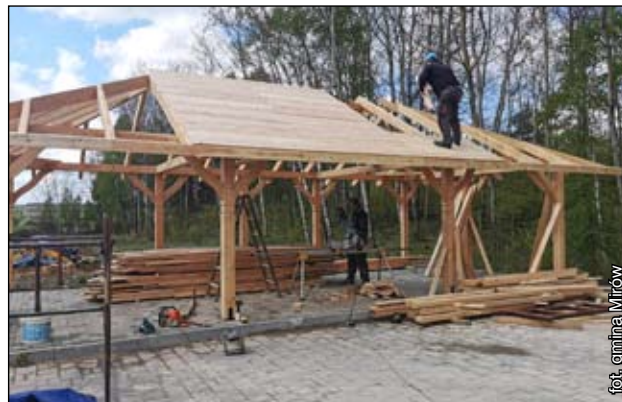
Konstrukcja altany jest już gotowa
