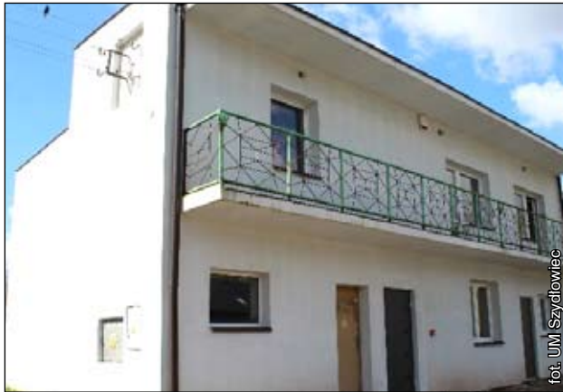
Świetlica wiejska już gotowa!
