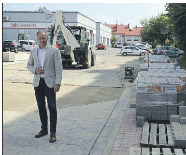
Prace przy Placu Wolności
