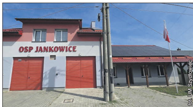
Nowa instalacja fotowoltaiczna na budynku OSP Jankowice
