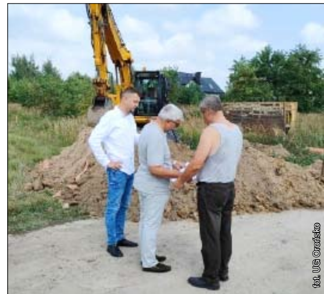
Budowa kanalizacji została zakończona
