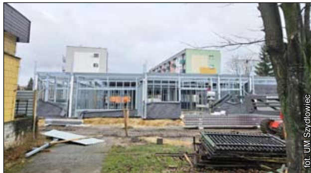
Budynek nowego przedszkola rośnie w oczach
