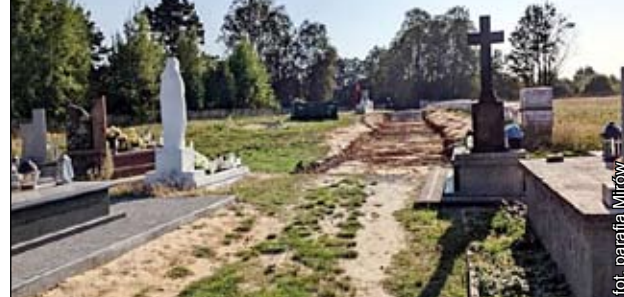
Prace na cmentarzu postępują
