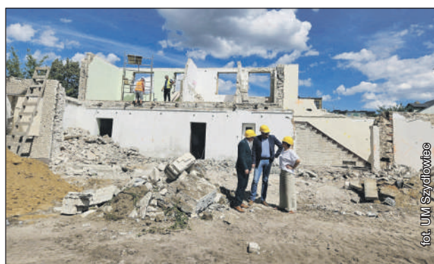
Tak wygląda obecnie teren budowy
