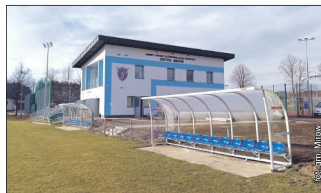
Prace w Rogowie dobiegają końca
