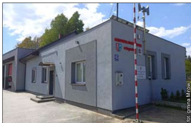
W budynku OSP potrzeba modernizacji systemu ogrzewania
