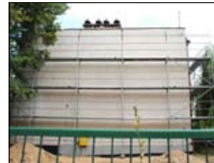
Trwają prace termomodernizacyjne
