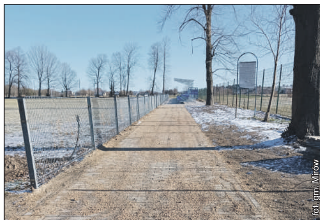
Rozpoczęto również budowę wjazdu na płytę boiska
