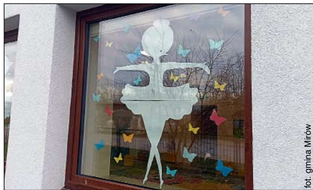
W budynku zostały wybite trzy okna
