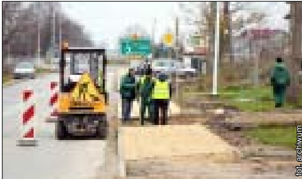
Remont drogi ma potrwać ok. 5 miesięcy
