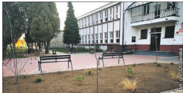
W ramach zadania utwardzono plac przy szkole, układając około 800 m 2 kostki brukowej. Zakupiono i zamontowano nowy przystanek autobusowy, odnowiono ogrodzenie szkoły, a także postawiono ławeczki i kosze na odpady.
