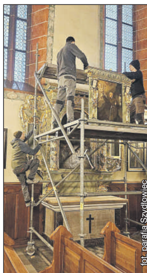
Tak wyglądały prace przy odnawianiu ołtarza
