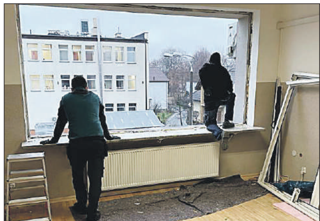
W budynku wymieniono okna
