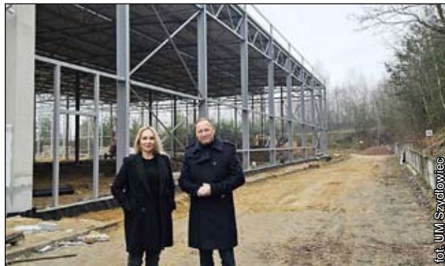
Budowa na terenie fabryki Oventrop trwa już od kilku miesięcy
