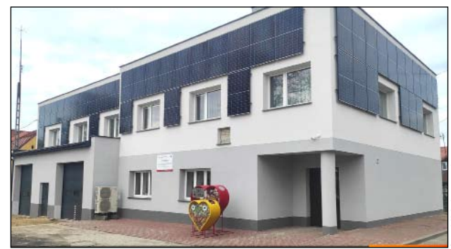
Budynek po termomodernizacji, z panelami fotowoltaicznymi na ścianach
