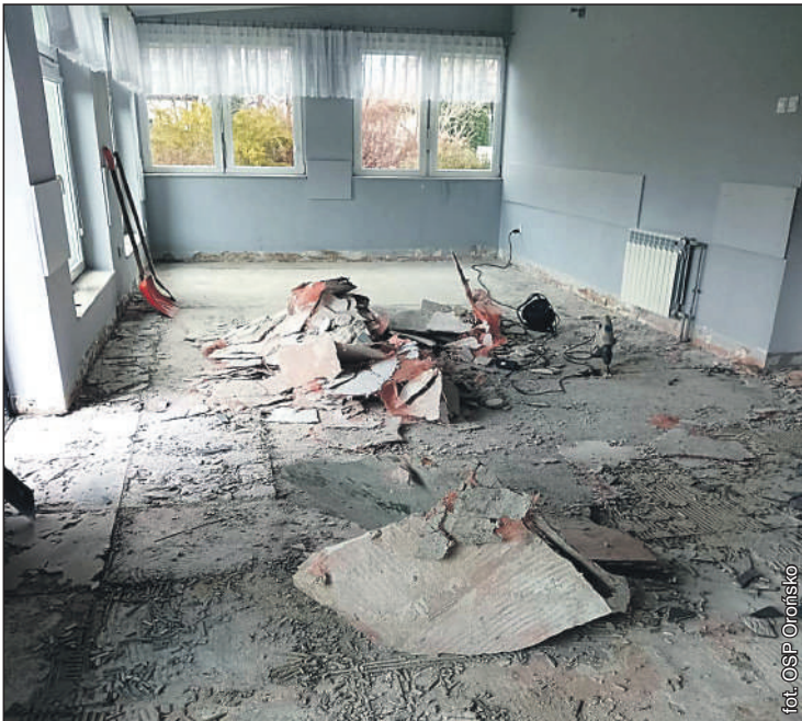
Tak wyglądał remont
