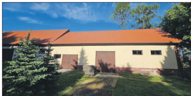
Prace nad nowym dachem zakończone
