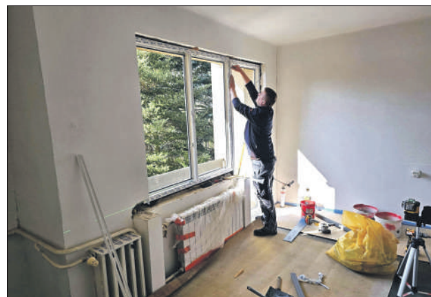
Prace idą w dobrym tempie
