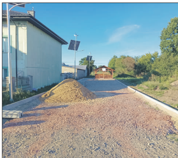
Po dokonaniu przebudowy zjazdu, wykorytowaniu i stabilizacji podłoża kruszywem łamanym, zostało wykonane okrawężnikowanie utwardzonego placu
