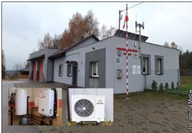
Modernizacja systemu ogrzewania w OSP Rogów
