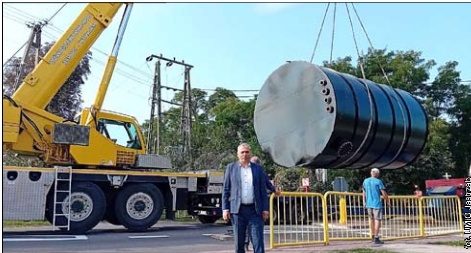
Nowa sieć wodociągowa umożliwi podłączenie przylegających nieruchomości do sieci
