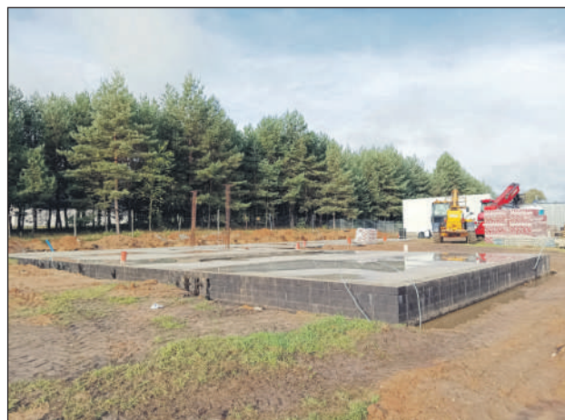
Prace przy rozbudowie postępują zgodnie z planem, dotychczas wykonano ławy i ściany fundamentowe
