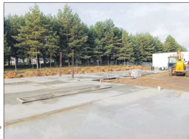
Prace przy rozbudowie postępują zgodnie z planem, dotychczas wykonano ławy i ściany fundamentowe
