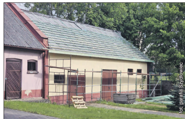
Rozpoczęły się prace remontowe związane z wymianą dachu
