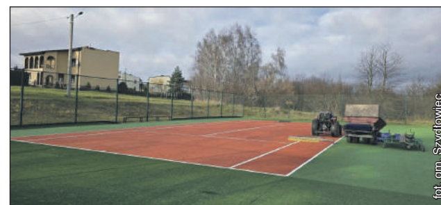
Trwa modernizacja kortów tenisowych zlokalizowanych przy ul. Sportowej w Szydłowcu
