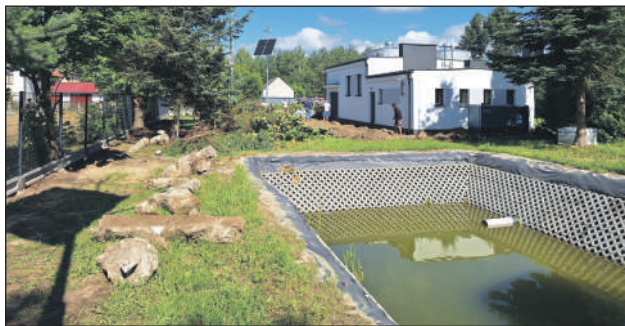
Ujęcie wody w Mirówku
