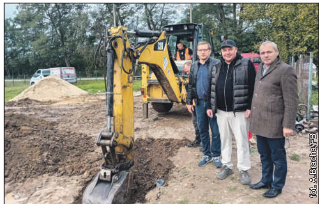
Rury azbestowe zostaną zastąpione wysokiej jakości rurami ciśnieniowymi PVC-U
