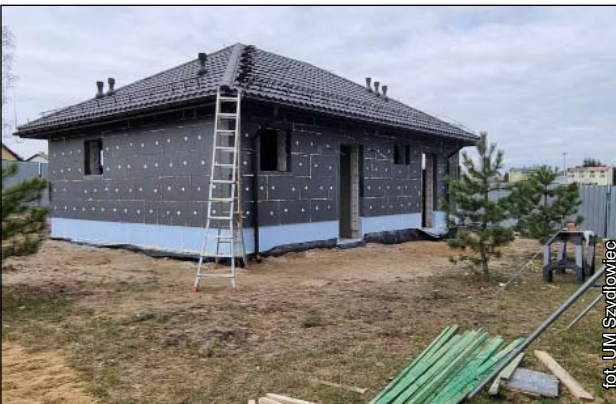
Nad zalewem powstaje nowy budynek
