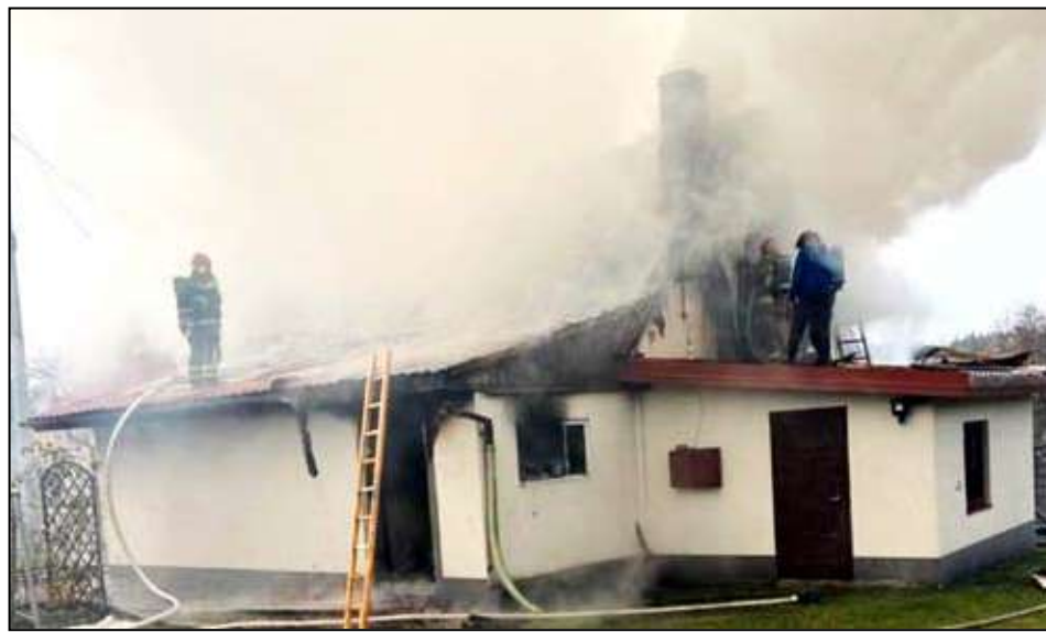
Dom po pożarze nadaje się do rozbiórki
