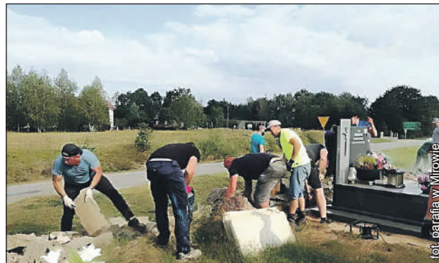
Rozbiórka starego ogrodzenia
