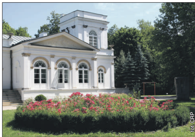
Remont ma potrwać do 2026 r.
