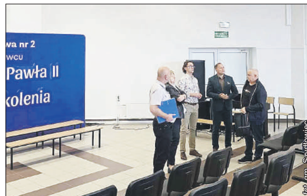
Odbiór instalacji klimatyzacji w PSP nr 2
