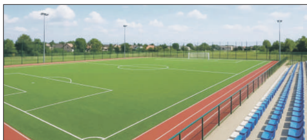
Jak poinformował starosta, na wniosek wykonawcy – firmy Panorama Obiekty Sportowe – zmieniono lokalizację masztów oświetleniowych
