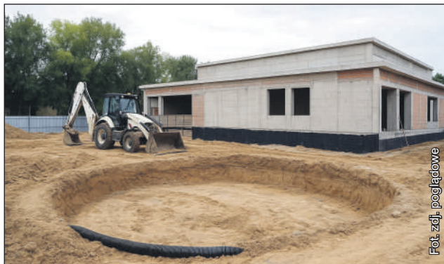
Jak odpowiada starosta Robert Górlicki budowa basenu podzielona jest na dwa etapy
