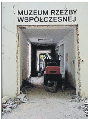
Trwają prace remontowe
