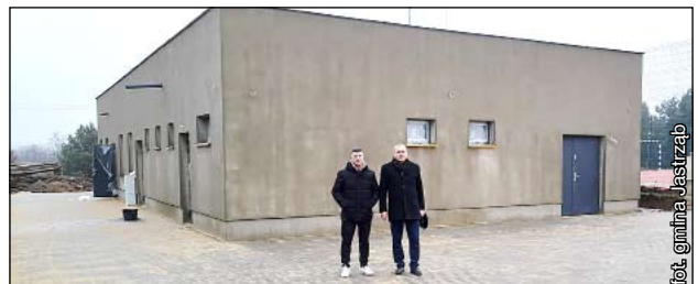
Trwa budowa nowoczesnego zaplecza szatniowo-sanitarnego w Jastrzębiu
