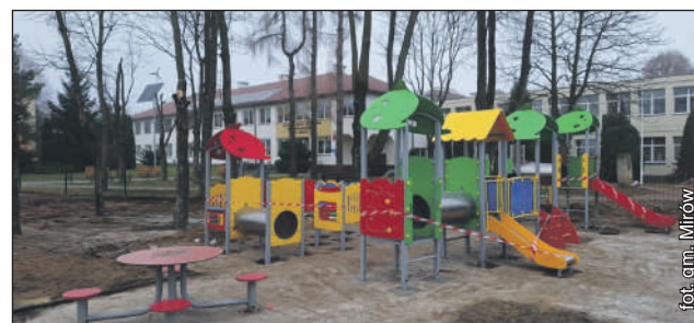
Przy Żłobku Gminnym w Mirowie trwają intensywne prace związane z przebudową placu zabaw
