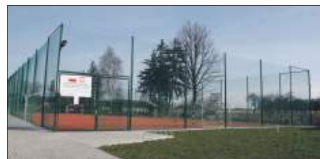
Boisko wielofunkcyjne przy PSP w Woli Lipienieckiej
