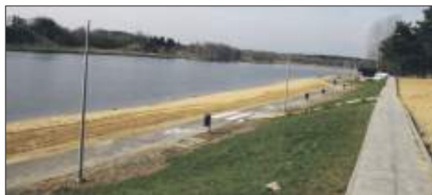
Ścieżka pieszo - rowerowa (w trakcie realizacji)
