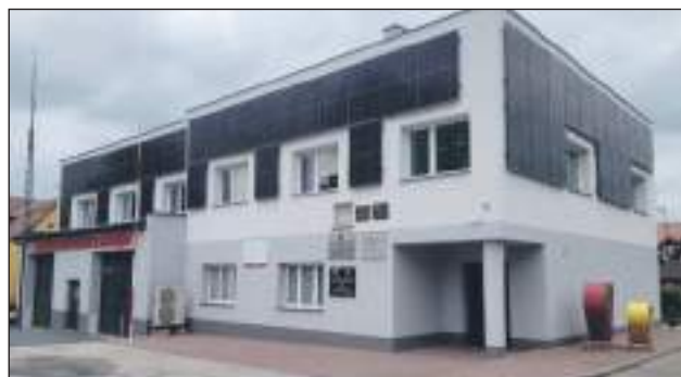
Termomodernizacja budynku OSP oraz Świetlicy Środowiskowej w Jastrzębiu
