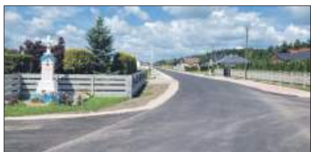
Przebudowa drogi - Wola Lipieniecka Duża - Kuźnia
