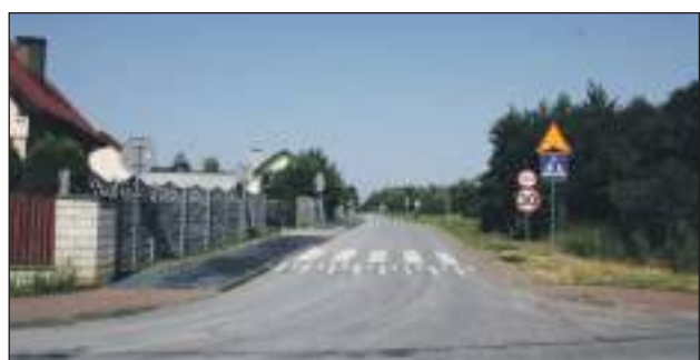
Budowa drogi - ul. Ks. Strzeleckiego w Jastrzębiu (węzeł do drogi ekspresowej)
