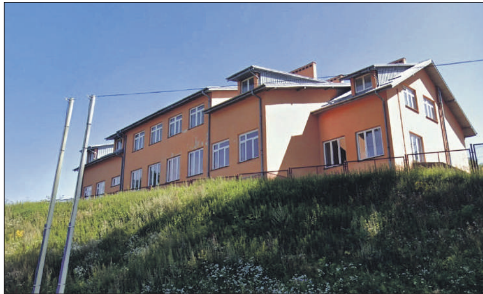
Gmina Szydłowiec pozyskała ponad 2,1 mln zł z funduszy unijnych na realizację projektu termomodernizacji dwóch budynków użyteczności publicznej
