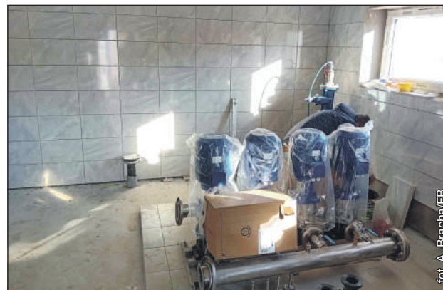
Inwestycja obejmuje kompleksową renowację
