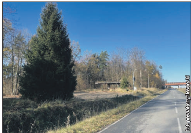
Prace rozbiórkowe zostały zakończone
