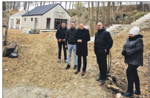
Już latem 2025 r. będzie można korzystać z nowej infrastruktury
