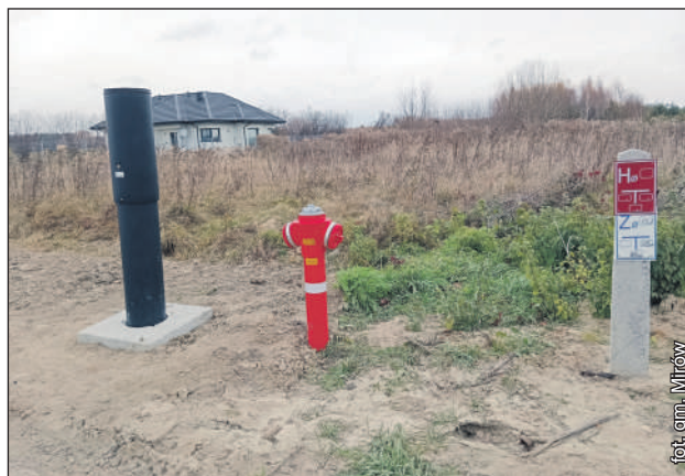
Dzięki otrzymanemu finansowaniu przebudowano lub wybudowano około 5km sieci wodociągowej w Mirowie Starym, Mirówku i Rogowie
