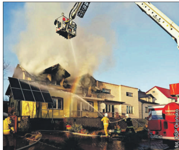
11 zastępów straży pożarnej gasiło pożar
