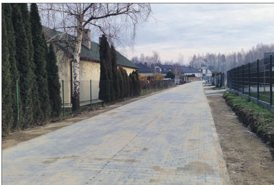
Przebudowa drogi gminnej w m. Zdziechów-Poręba
