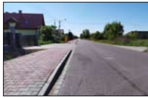
Przebudowana droga gminna Rogów – Bieszków Górny
