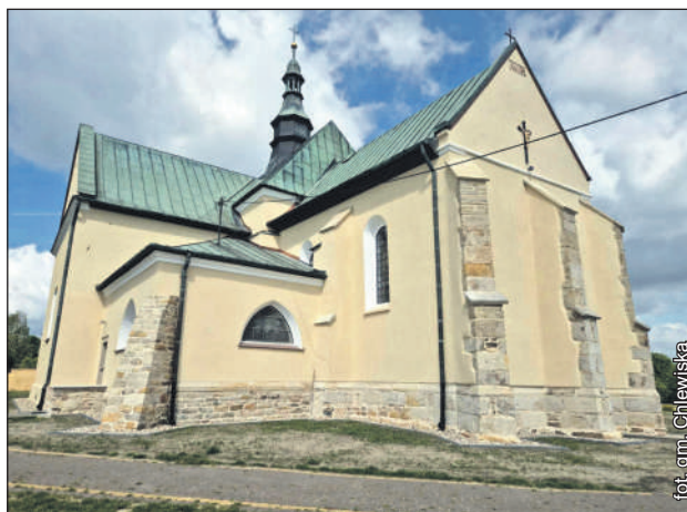
Kościół przejdzie kolejny etap remontu
