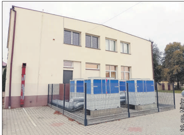
Celem modernizacji jest podniesienie efektywności energetycznej budynków
