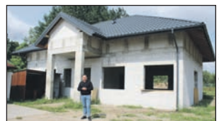
Prace przy świetlicy
