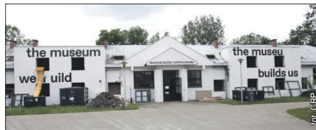
Centrum Rzeźby Polskiej w Orońsku oficjalnie rozpoczęło prace budowlane
