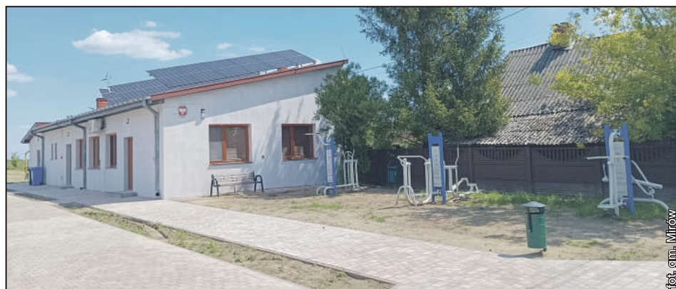
Rozpoczęły się prace przy elewacji budynku
