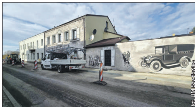
Trwają prace przy ul. Kilińskiego
