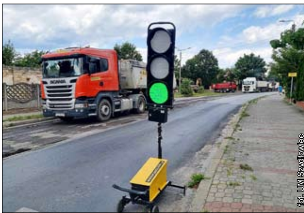
Sygnalizacja świetlna pomaga kierować ruchem podczas remontu
