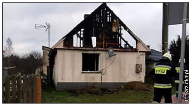
Po akcji gaśniczej z domu niewiele zostało...
