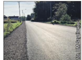
Budowa drogi w miejscowości Barak
